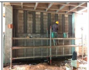
MURO DE CONTENCIÓN SOTANO
