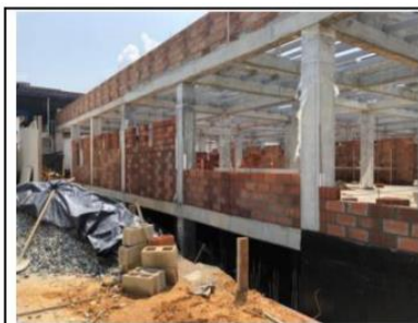
MAMPOSTERÍA EN EJE A
