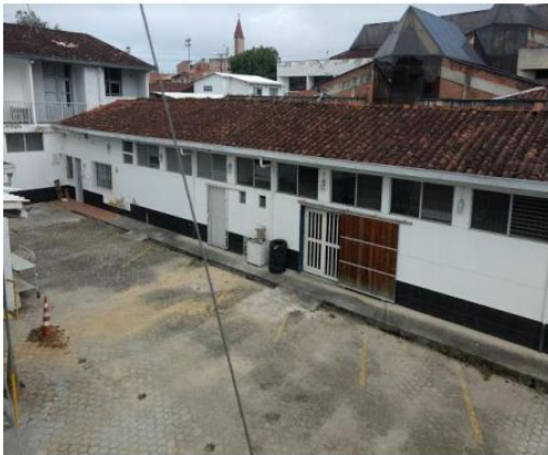
ESTADO INICIAL DE LA OBRA
